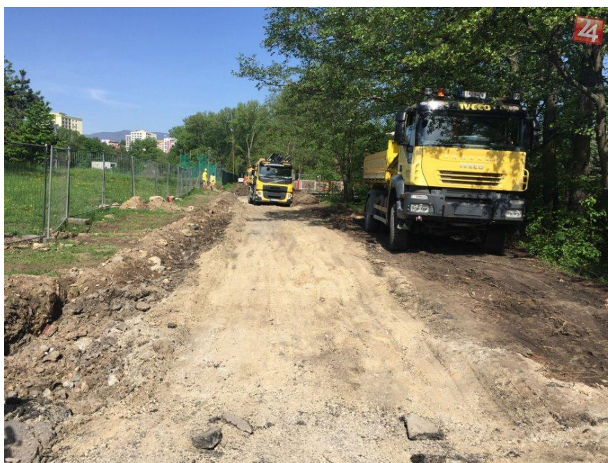
Obr. 28: Výstavba cyklotrasy ESC – Podlavice, Zdroj Bystrica 24
